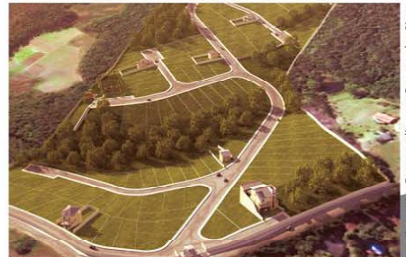
Foto: Ilustrativa Empreendimento Reserva dos Pires
